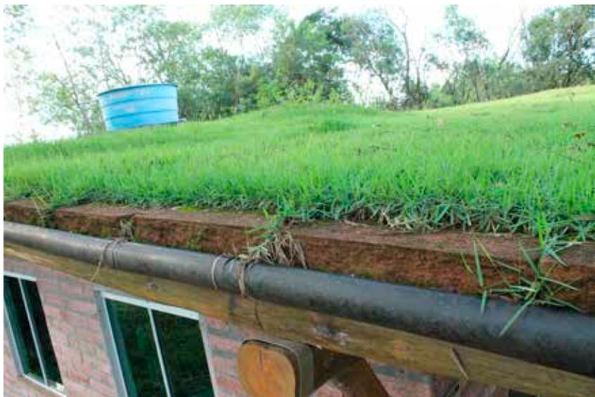
Para construção do telhado foram utilizado materiais locais: madeira roliças e tábuas, geomembrana (lona de uma 1 micra), terra local, peneira com material orgânico e composição física equilibrada (argila, areia, silte e matéria orgânica) e plantio de grama que foi antecedido pela aplicação de farinha de rochas para mineralização em todo a área do telhado.
